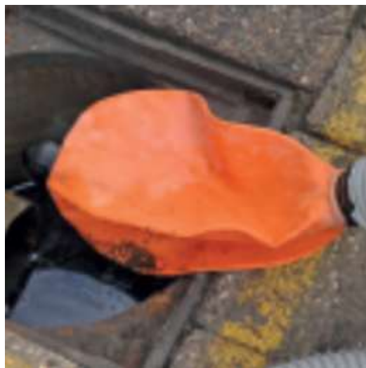
Collegare il ROM SmokeStopper all'estremità del tubo di alimentazione del fumo
